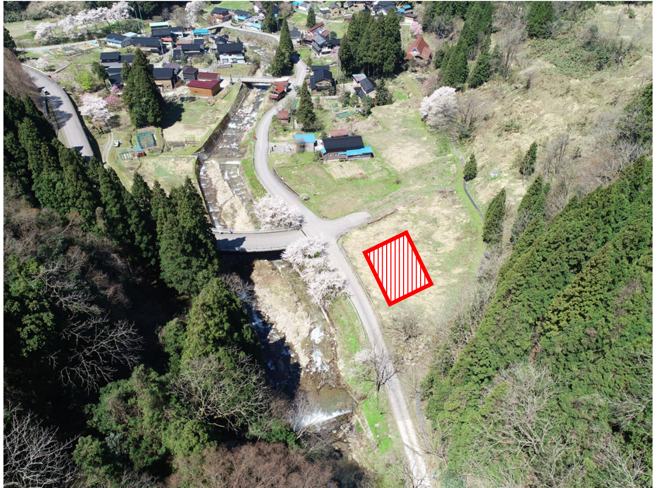
発電施設建設予定地
