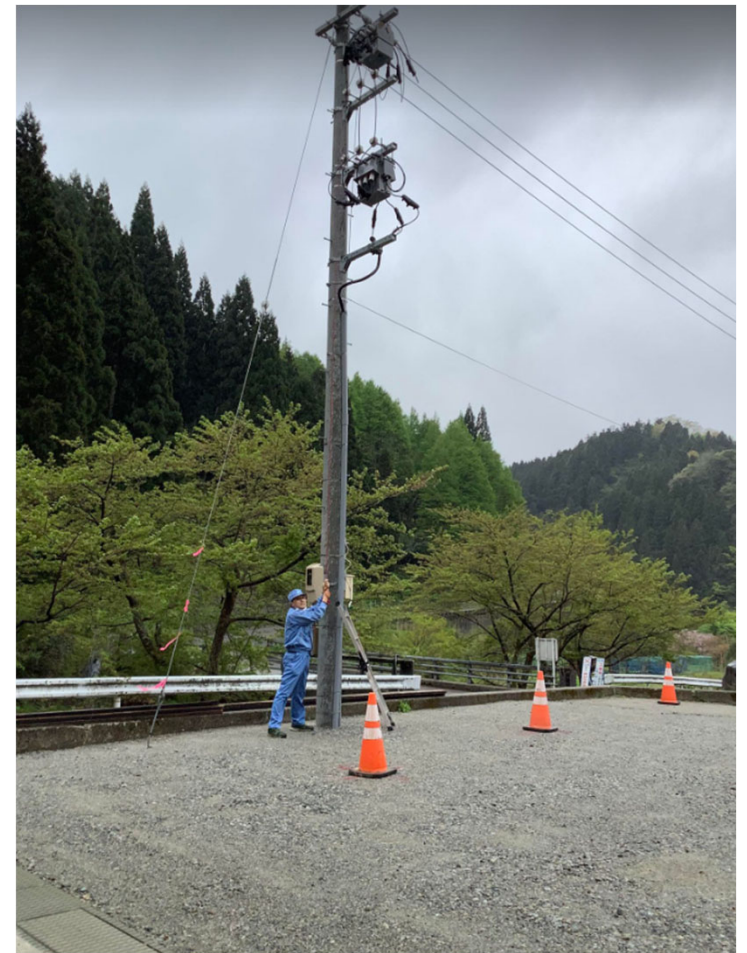
系統連系作業完了
