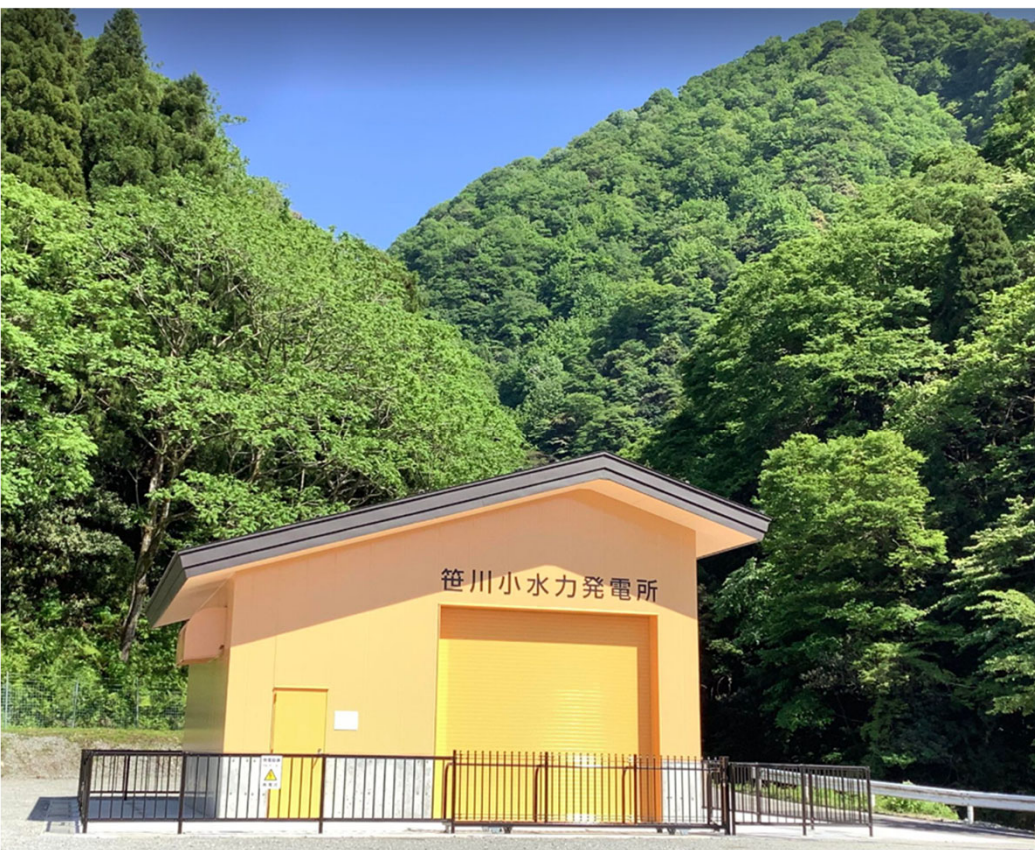
発電所建屋完成
