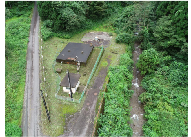
写真3：老朽化した簡易水道設備 全体写真
