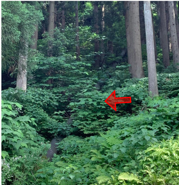
写真4：笹川に残る旧発電施設の鉄管
