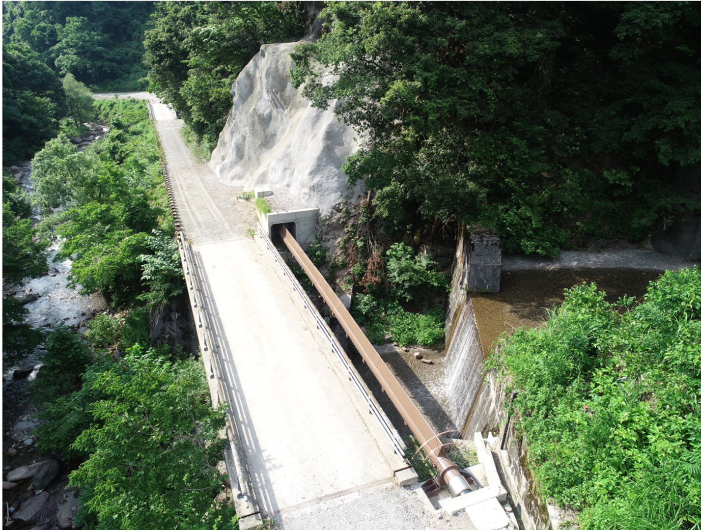
小鷲谷水管橋
