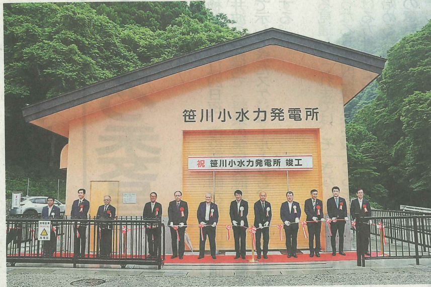
全国初の仕組みで完成した小水力発電所完成を祝う関係者 —朝日町笹川
