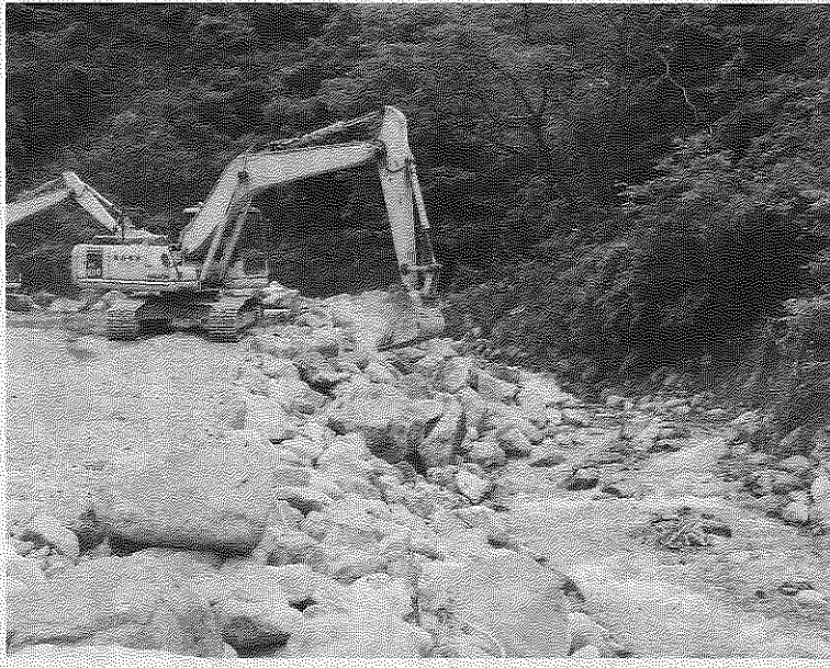
朝日町の笹川では小水力発電所の建設工事が進む(6月)
